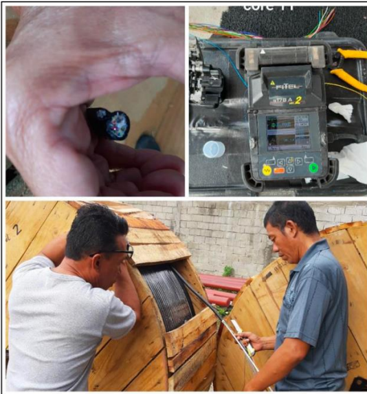
Gambar 5. Pemeriksaan dan Uji Penyambungan Kabel 24 core Tujuan dari pengecekan dan pengujian ini adalah untuk mengetahui kualitas dan berfungsinya kabel FO dan memastikan bahwa kabel yang sudah diadakan sesuai spesifikasi dan bisa digunakan.
