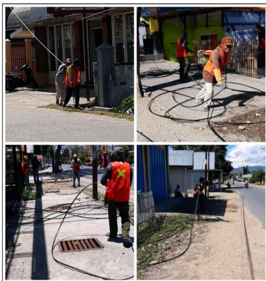
Gambar 7. Penarikan Kabel
