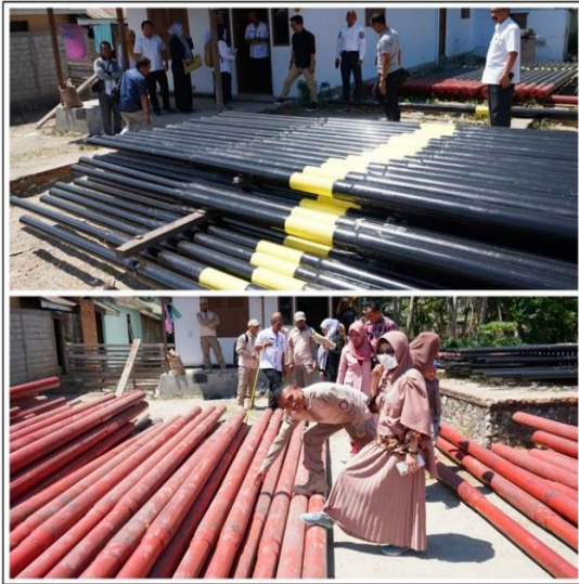
Gambar 4. Pemeriksaan dan pengukuran tiang 7 dan 9 Meter
