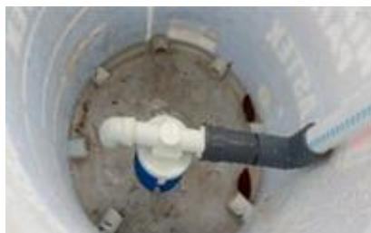
Gambar 5. Kran Otomatis pada Drum Penampung
